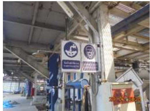
รูปที่ 35 ฝักบัวและอ่างล้างตาฉุกเฉิน
