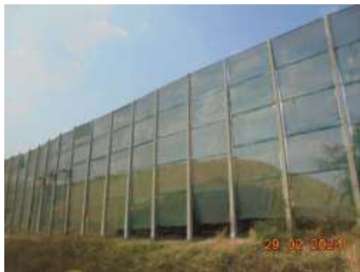
รูปที่ 10 โครงเหล็กติดตามข่ายล้อมรอบกองขาน้อย
