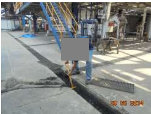
รูปที่ 22 การขุดลอกวางระบายน้ำในพื้นที่โครงการ
