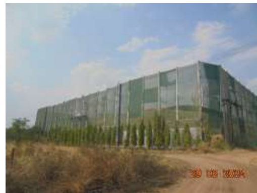
รูปที่ 10 โครงเหล็กติดตามข่ายล้อมรอบกองขาน้อย
