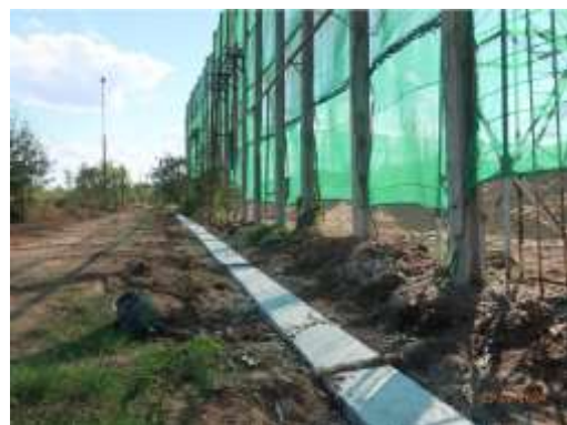
รูปที่ 23 วางระบายน้ำรอบกองขนำอ้อย
