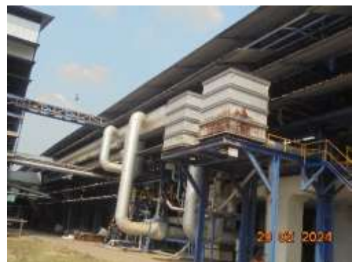
รูปที่ 19 อุปกรณ์ลดเสียง (Silencer)
