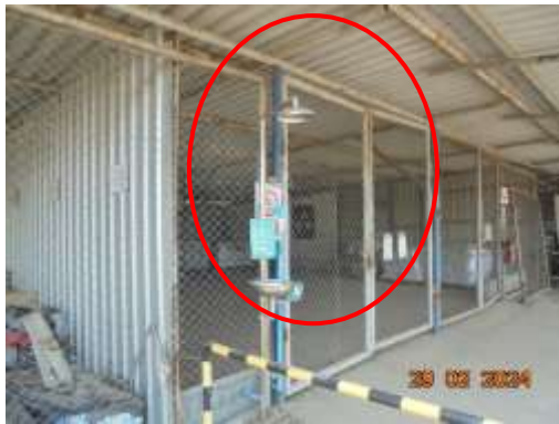
รูปที่ 35 ฝักบัวและอ่างล้างตาฉุกเฉิน
